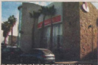
Los nuevos edificios en Palmares, para adaptarse a futuro a otros usos.
