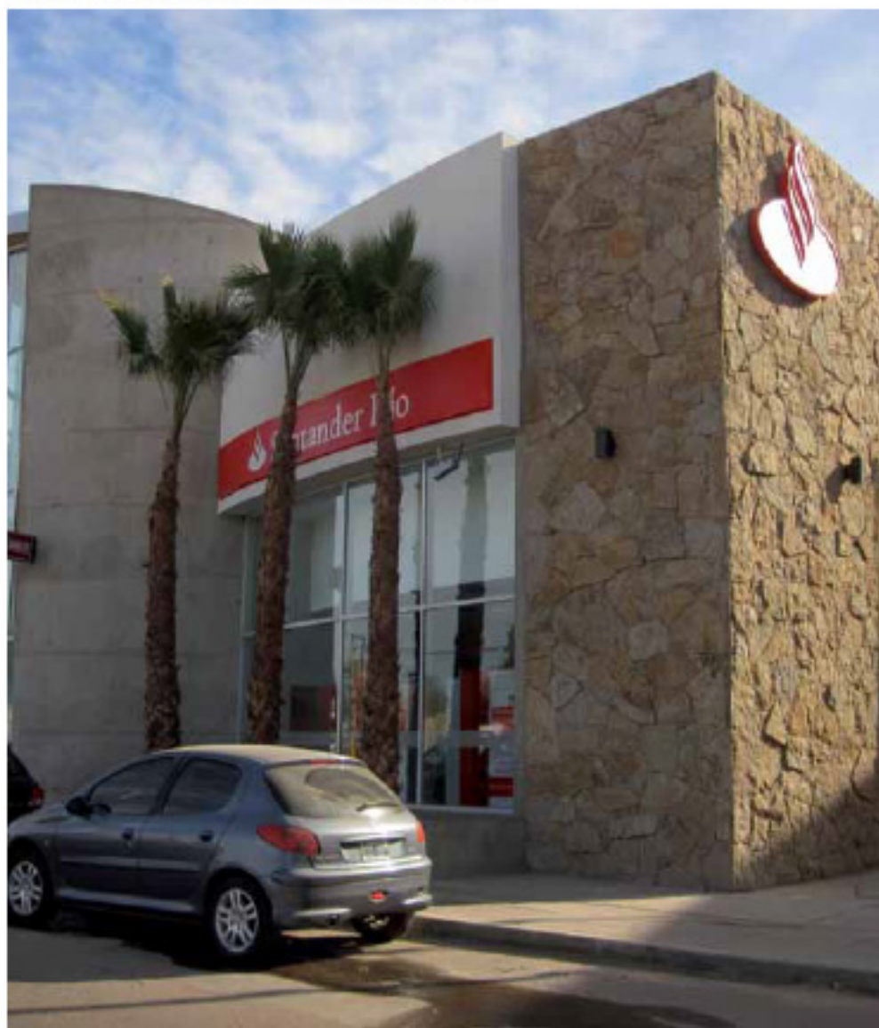
El tratamiento diferenciado de las fachadas según la orientación.
