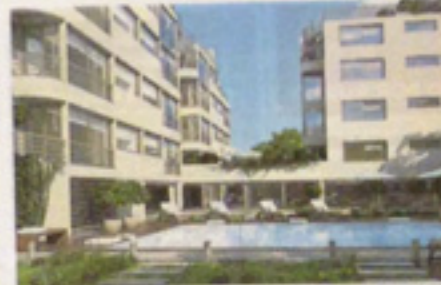
Escalera. El edificio se levanta en un área de densidad media
