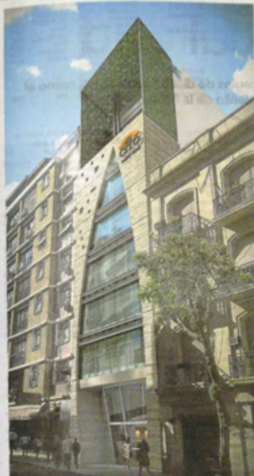
Fachada. La transparencia responde a las necesidades de iluminación.
